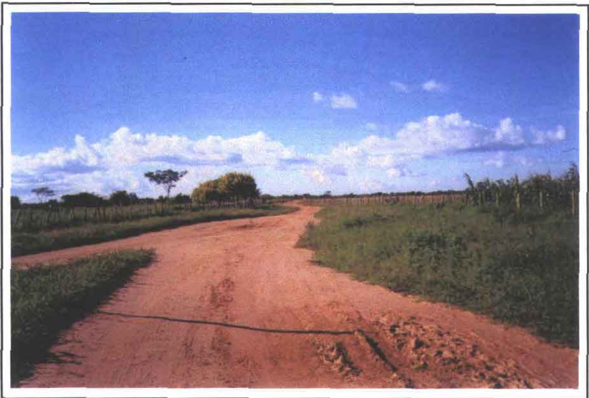
FOTO 04/07 - VISTA DO PONTO DA BIFURCAÇÃO DO SISTEMA ADUTOR POÇO PIONEIRO (CAPTAÇÃO)/ SEDE MUNICIPAL DE ARARIPE/ SERRA DA PERUA, COM VISTA PAR O INICIO DO PROVÁVEL TRAÇADO DO SISTEMA ADUTOR PARA O ABASTECIMENTO DA SERRA DA PERUA, QUE DISTA 20 km DESTE PONTO.
